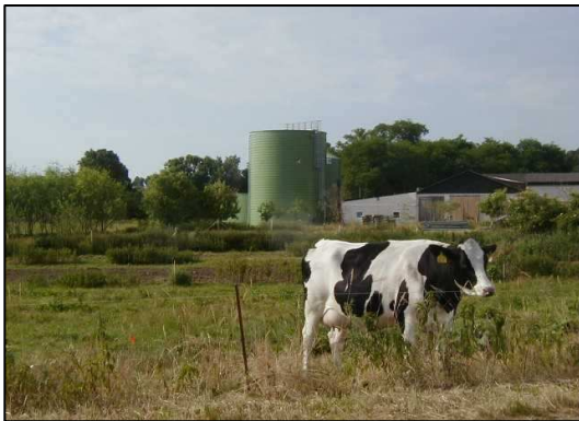
Biogasanlage für die Landwirtschaft in Warsow
