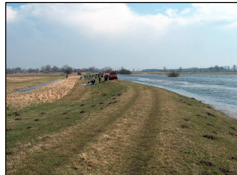
Hochwasser im Bereich Rhinow
