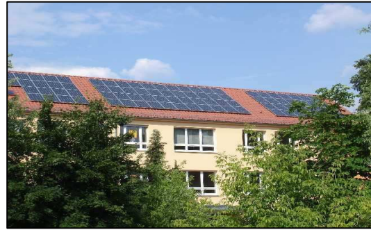
Solaranlage Europaschule Falkensee
